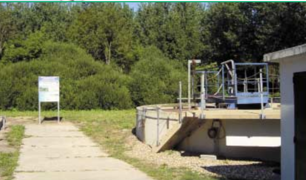
Station d'épuration existante
