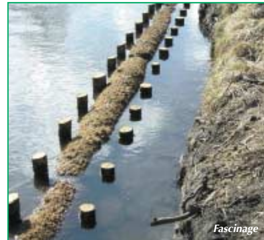
Double fascine préfabriquée et boudin géotextile
