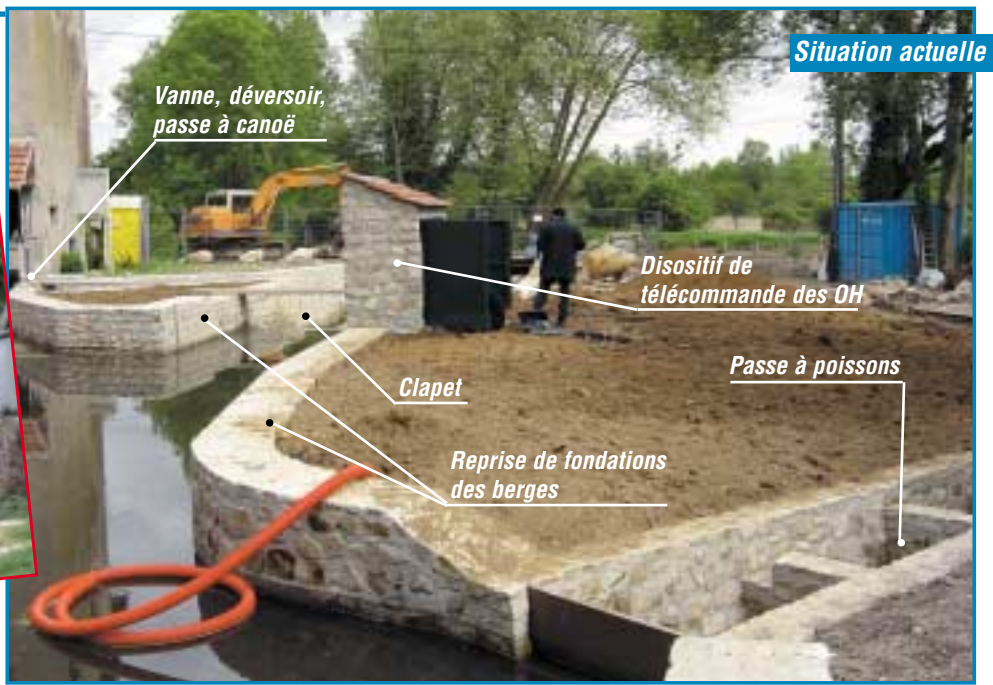
Mise en place des fondations d'une passe à poissons
