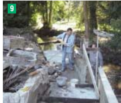
Mise en place des fondations d'une passe à poissons
