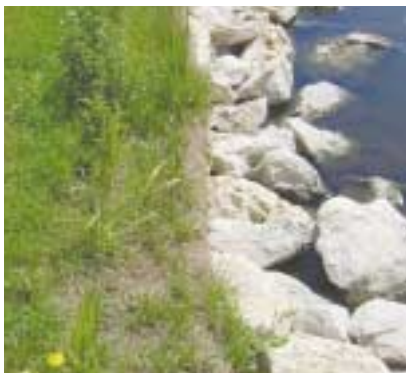
Talus végétalisé avec enrochement
