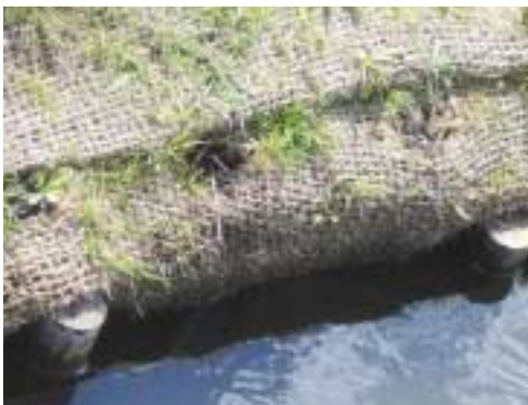
Protection de berges par tunage avant plantation
