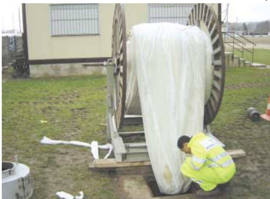
Réhabilitation de canalisation (chemisage)
