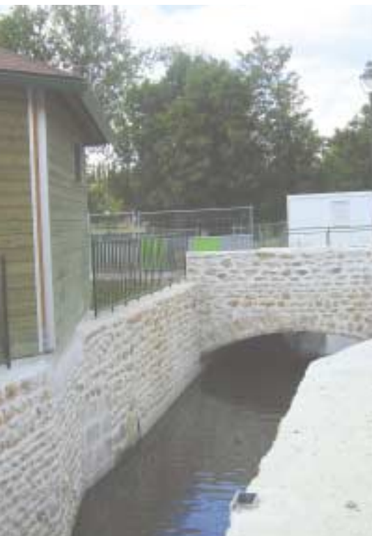
Complexe hydraulique d'Angoulême réhabilité
