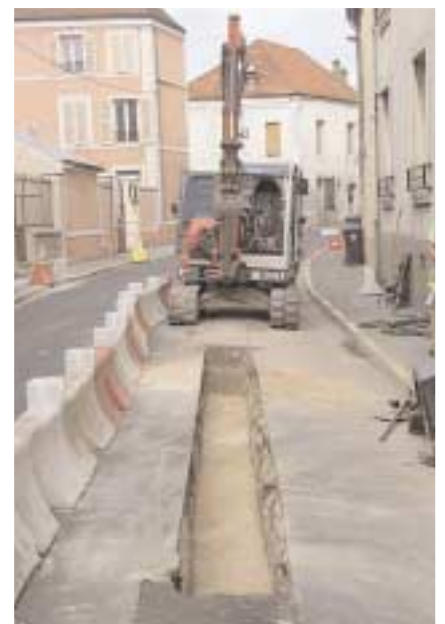
Tranchée permettant la pose d'une canalisation
