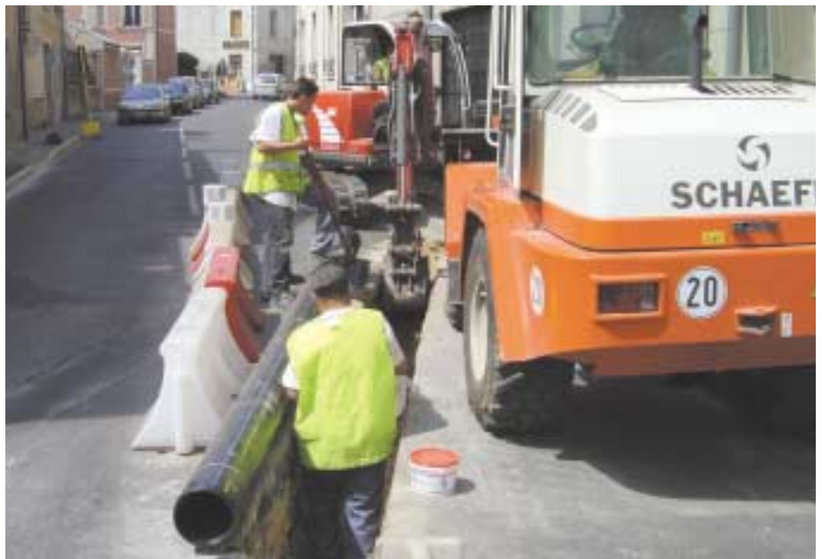
Préparation pour la mise en place de la canalisation
