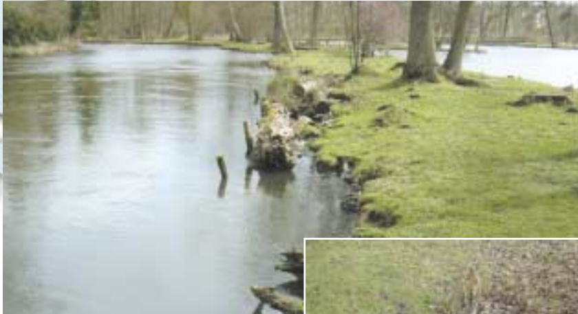
Berges érodées côté rivière
