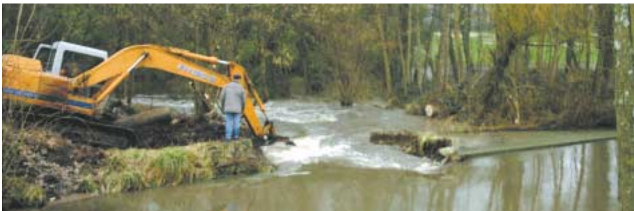
Travaux d'urgence pendant la crue
