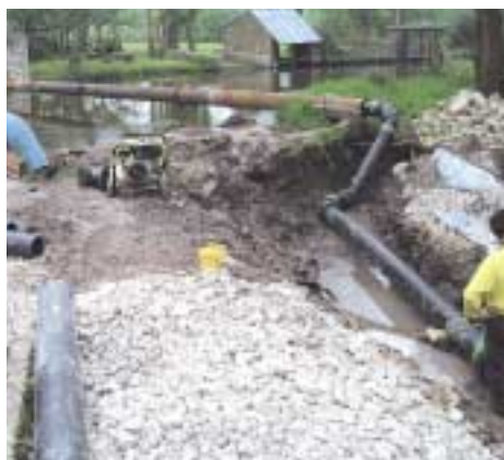
Enterrement de la canalisation
