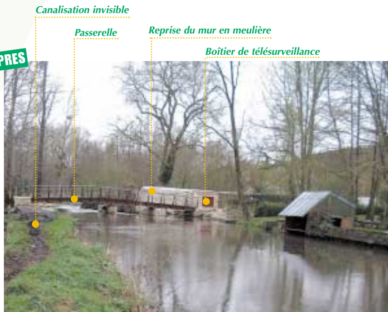
Ouvrages et passerelle avant et après réhabilitation
