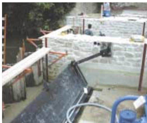
Pose d'un clapet
